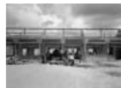
トヴァイン小学校⑮ 建設中
