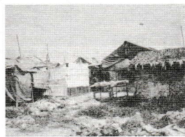
スラム街の住居。 6/26の嵐で100戸が倒壊したそうです。
